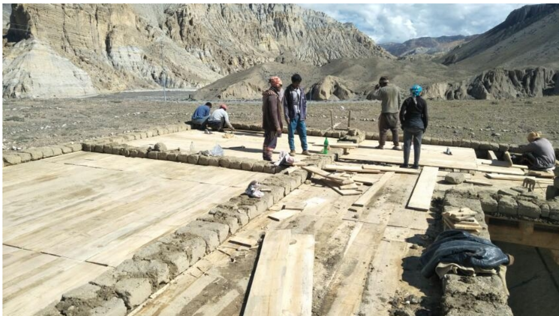
Préparation du plafond qui sera recouvert d'un film hydrofuge avant d'être recouvert de la terre battue qui fera le sol de la terrasse.
